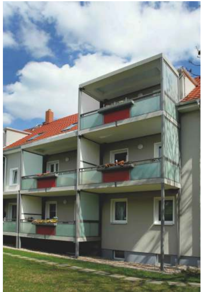
(2) Geradliniger Aluminium-Beton Balkon mit aufstehendem Glasgeländer und Betondach
