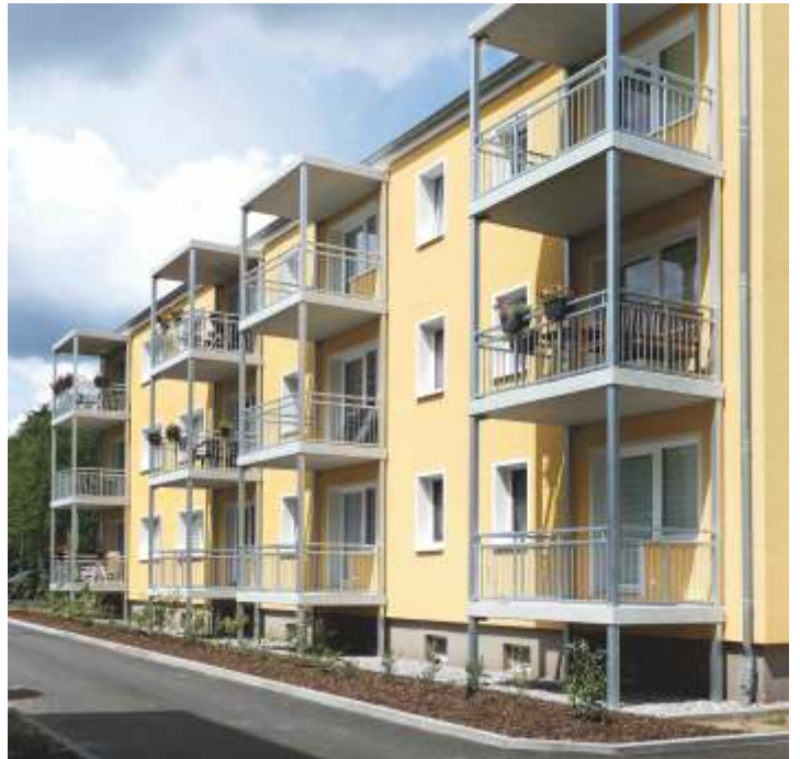
(32) Luftige Balkone, Stahl feuerverzinkt mit Betonplatte
