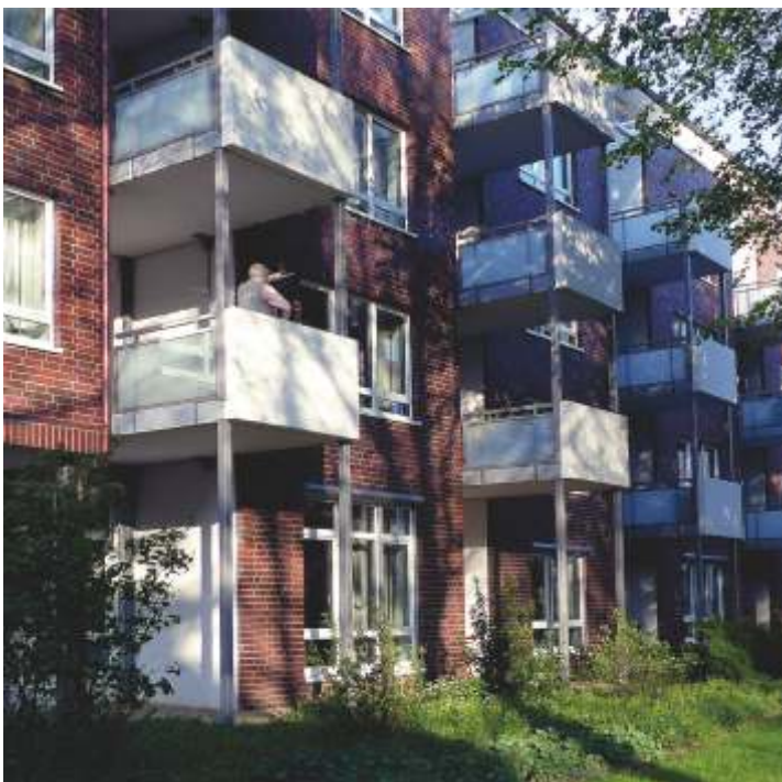
(30) Massive Betonbrüstung im Wechsel mit leichter Glasfüllung
