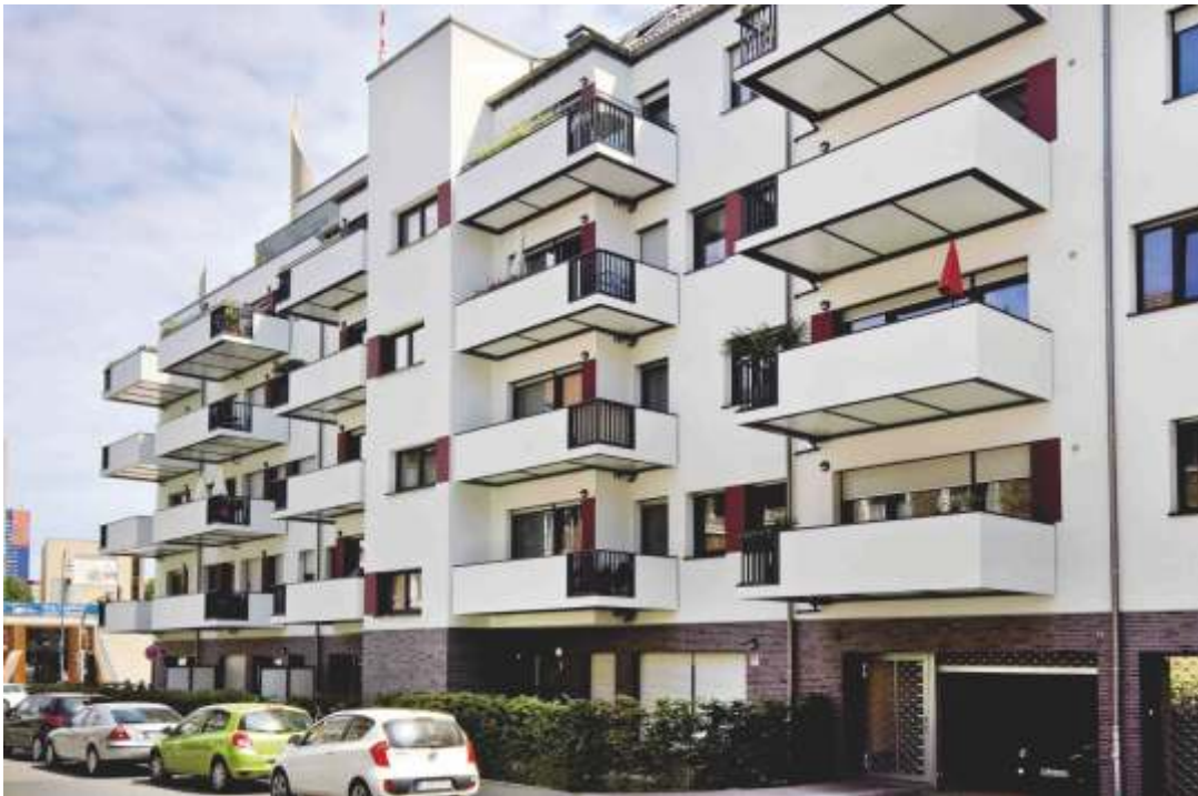
(21) Extravagante Metall-Kragbalkone mit verputzter Brüstung (Putzträgerplatte auf Metallkonstruktion)
