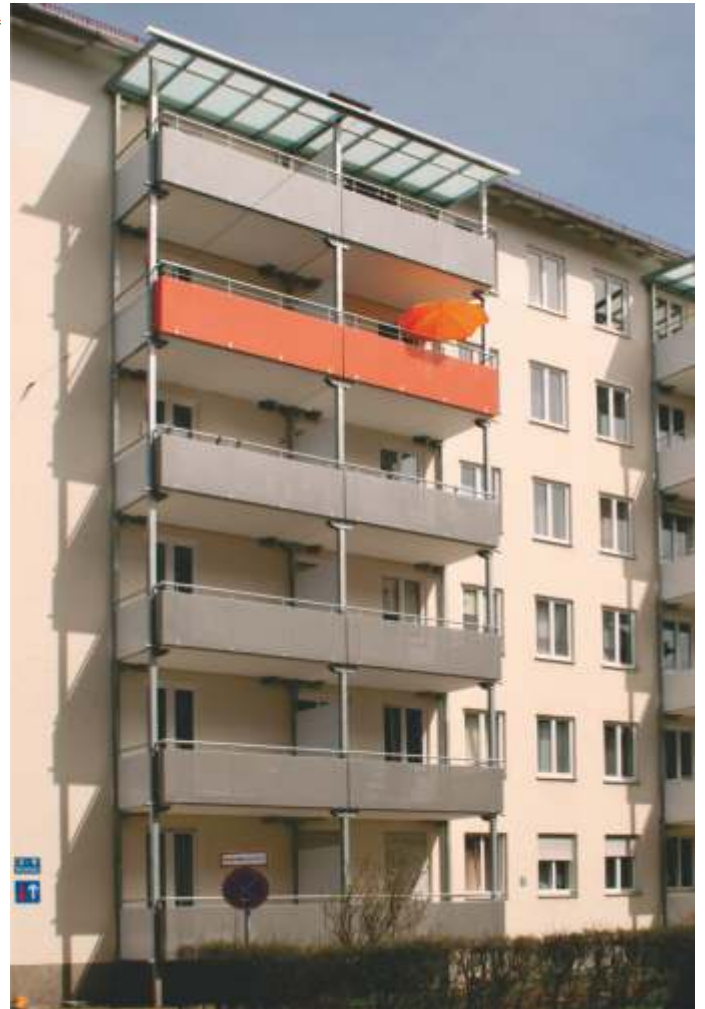
(43) Lochblechfüllung auf Stahlgeländer
