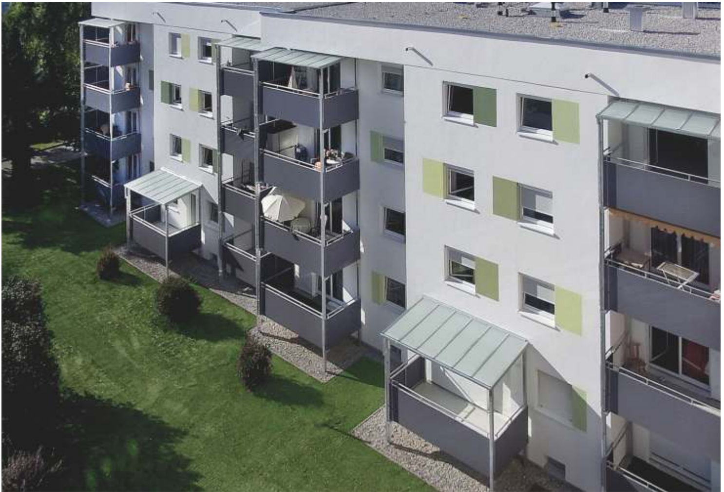
(4) Schlichte Stahlbrüstung; die genietete HPL-Füllung verdeckt die Betonplatten
