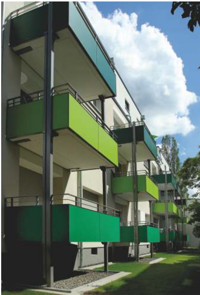
(34) Farbliche Variation der Verkleidungsplatten (HPL, gerahmt auf Metallunterkonstruktion)
