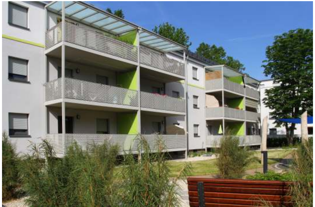
(12) Durchscheinende Balkonverkleidung aus Streckmetall
