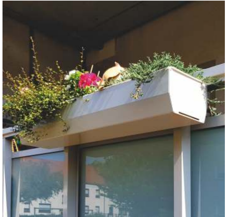
(26) Blumenkastenträger aus Aluminium-Strangpressprofil
