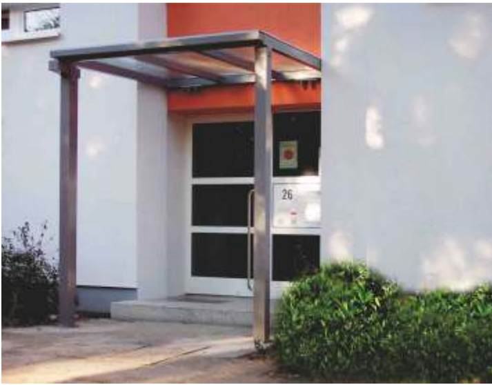
(46) Großzügiges Alu-Glas-Vordach mit Stützen
