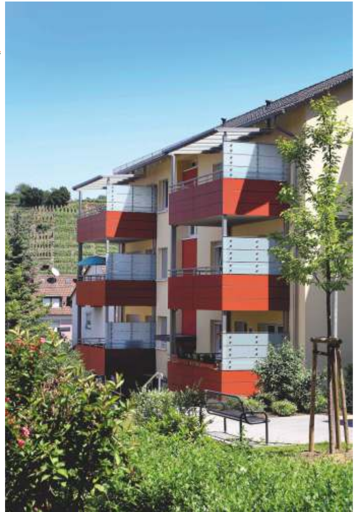
(29) Geradlinige Brüstungsverkleidung mit Glas- und HPL-Streifen
