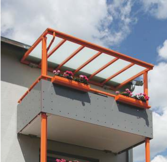
(18) Großzügige Balkonerweiterung nach Abbruch früherer Nischenbalkone
