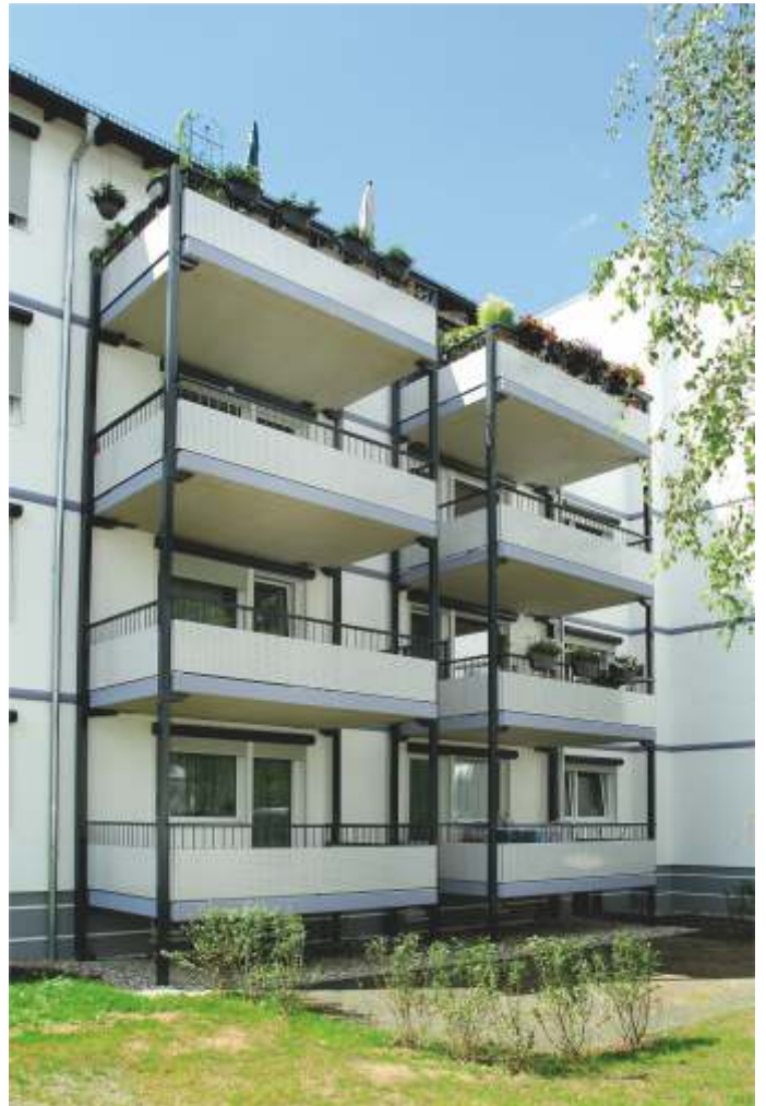
(37) Stahl-Beton-Balkone mit zur Fassade abgestimmter Lochblechverkleidung
