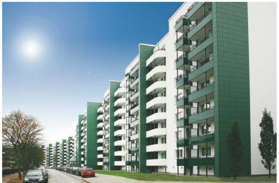
(33) Brüstungsverkleidung aus farbigem Glas im Wechsel mit massiven Betonbrüstungen (Siebdruck auf VSG aus 2xESG)
