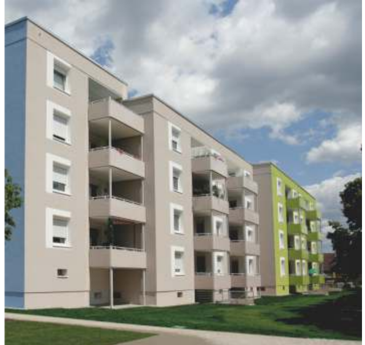
(35) Zur Fassade abgestimmte Balkonbrüstung aus farbigen Blechen
