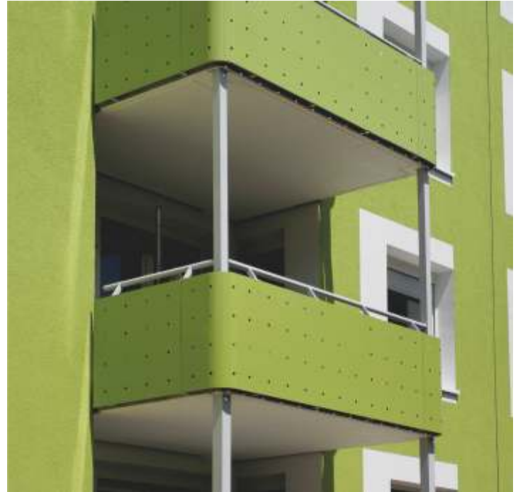
(11) Moderne Brüstungsverkleidung mit farbigen Lochblech als gerundete Eckausbildung
