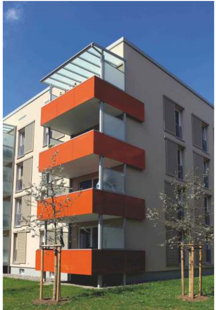
(16) Scheinbarer Eckbalkon mit vollflächiger Blechverkleidung
