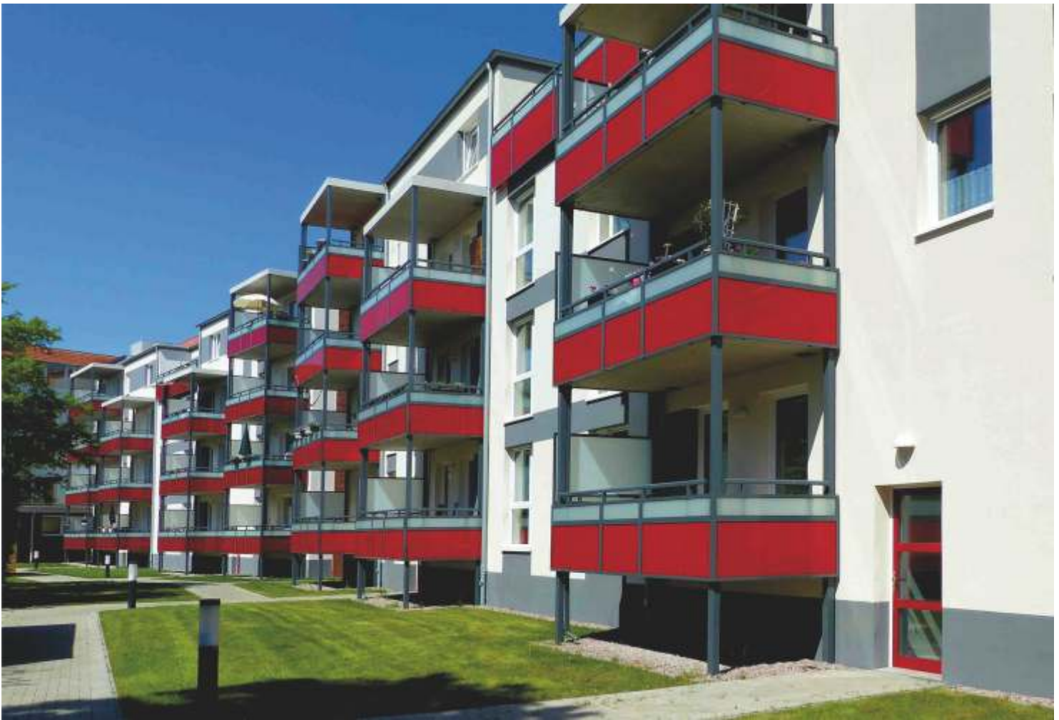
(40) Außergewöhnliche Brüstungsverkleidung mit einfarbig bedrucktem Verbundglas
