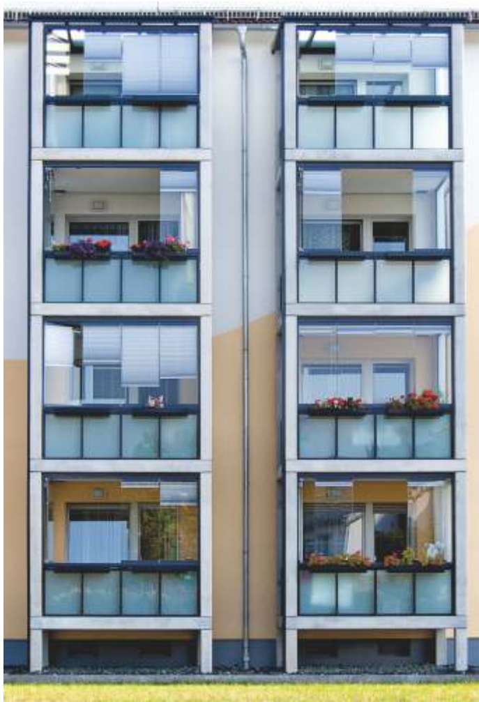
(15) Moderner Balkon in denkmalkonformer Optik; eng gesetzte Füllstäbe aus Alu-Kastenprofil 40x10
