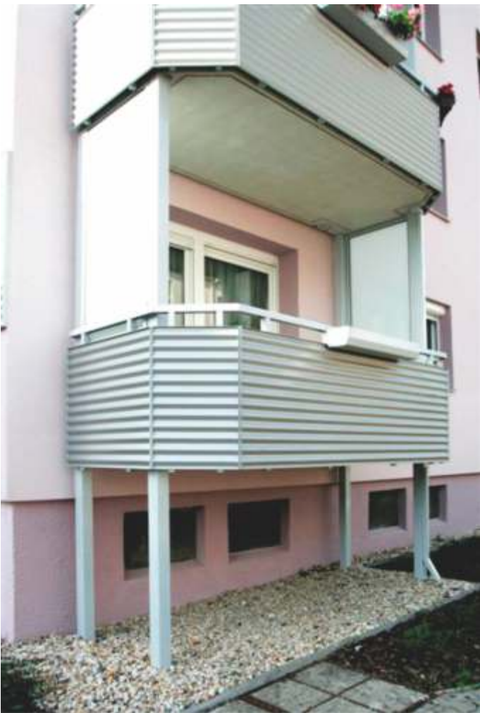
(22) Brüstungsverkleidung mit Wellblech
