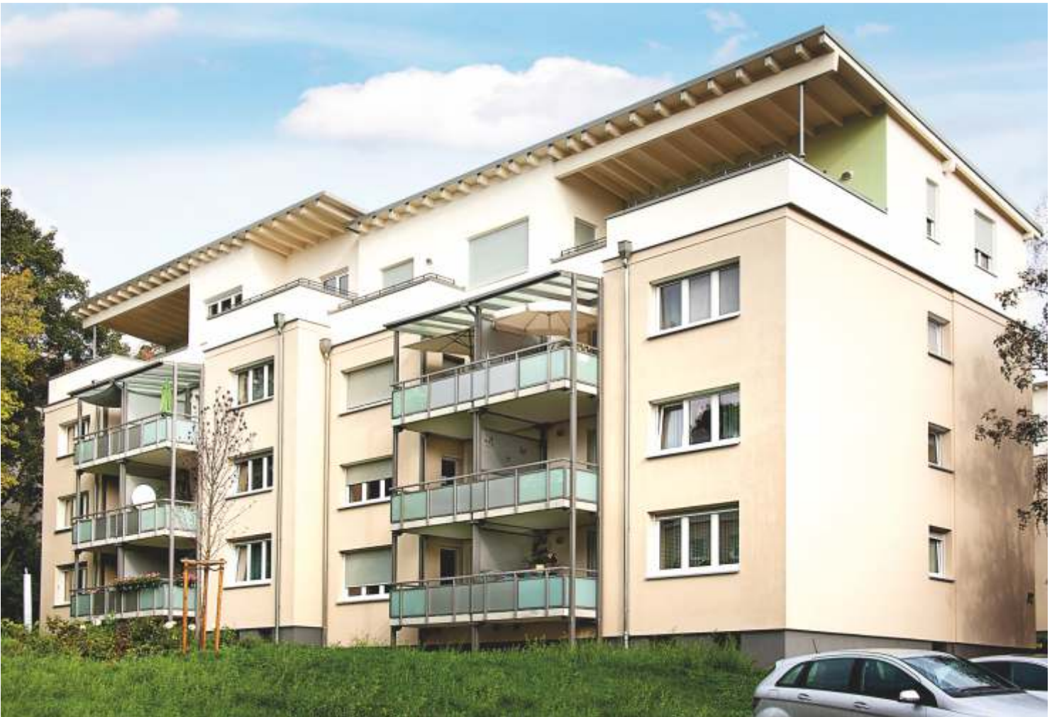
(18) Großzügige Balkonerweiterung nach Abbruch früherer Nischenbalkone
