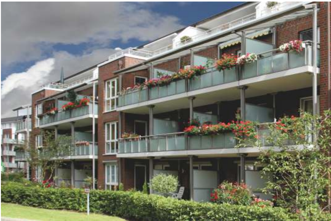
(45) Alu-Beton-Balkone mit aufstehendem Glasgeländer (VSG mit mattweißer Folie)
