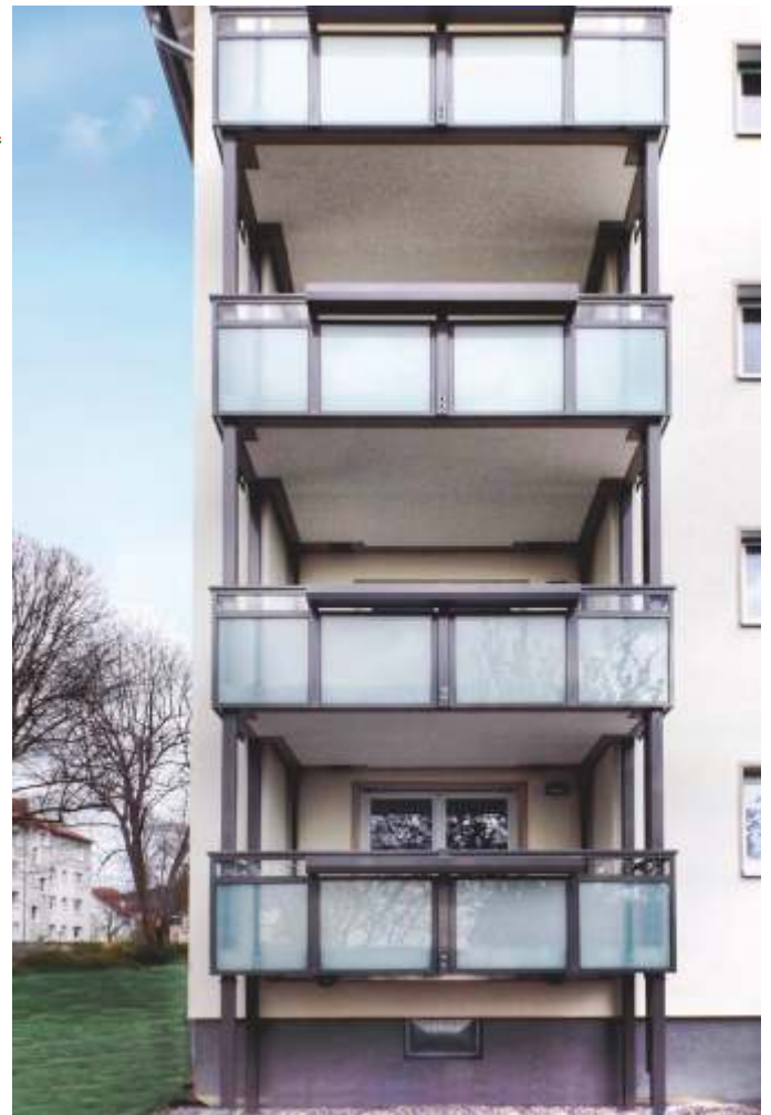
(5) Nischenerweiterung und geschlossene Glasbrüstung, Wechsel von Mattglas auf Klarglas
