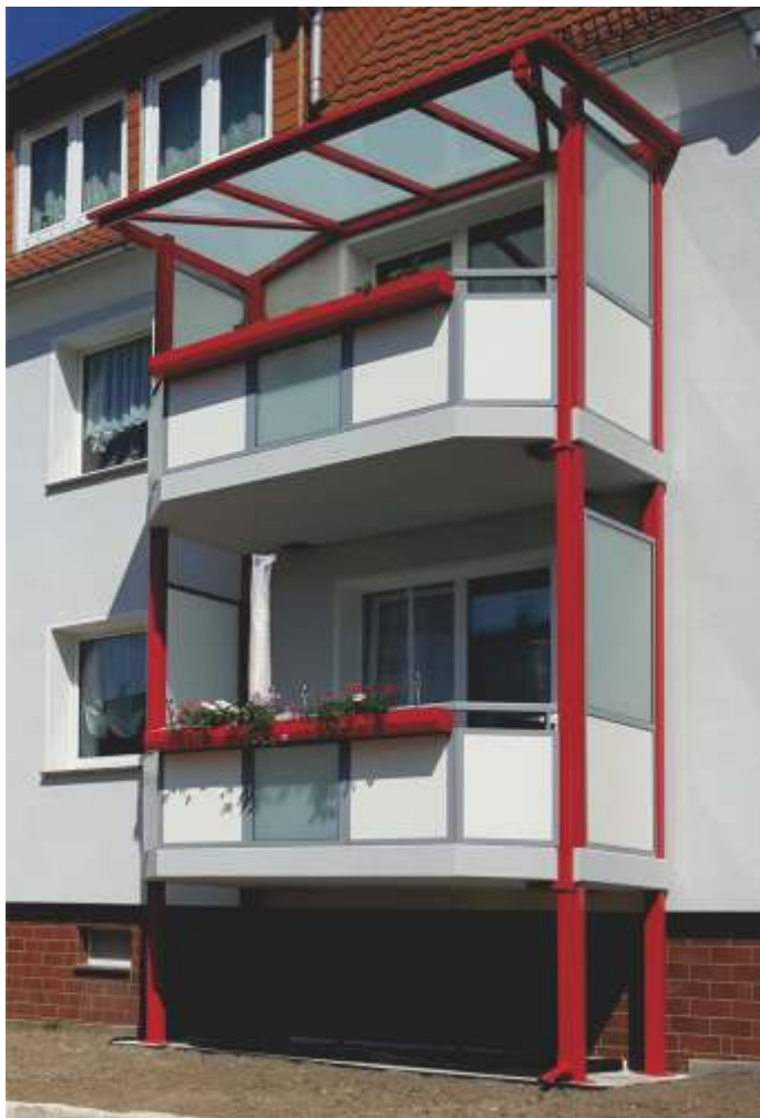
(31) Moderner Sechseckbalkon mit Walmdach
