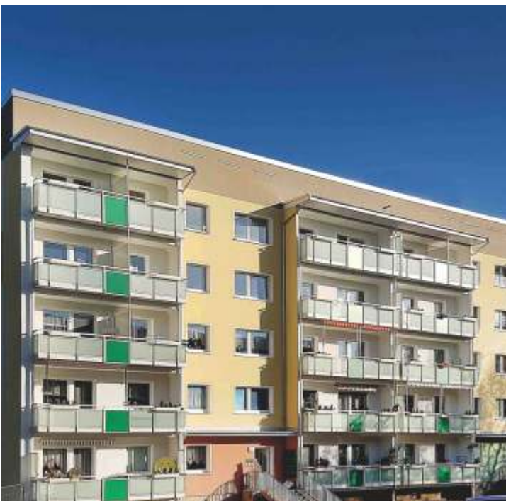
(42) Erweiterung bestehender Plattenbalkone durch auskragenden Alu-Bodenrahmen
