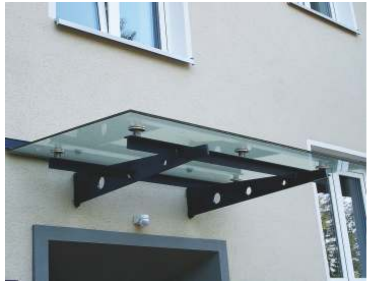
(49) Stahl-Vordach mit punktgelagertem Verbundsicherheitsglas
