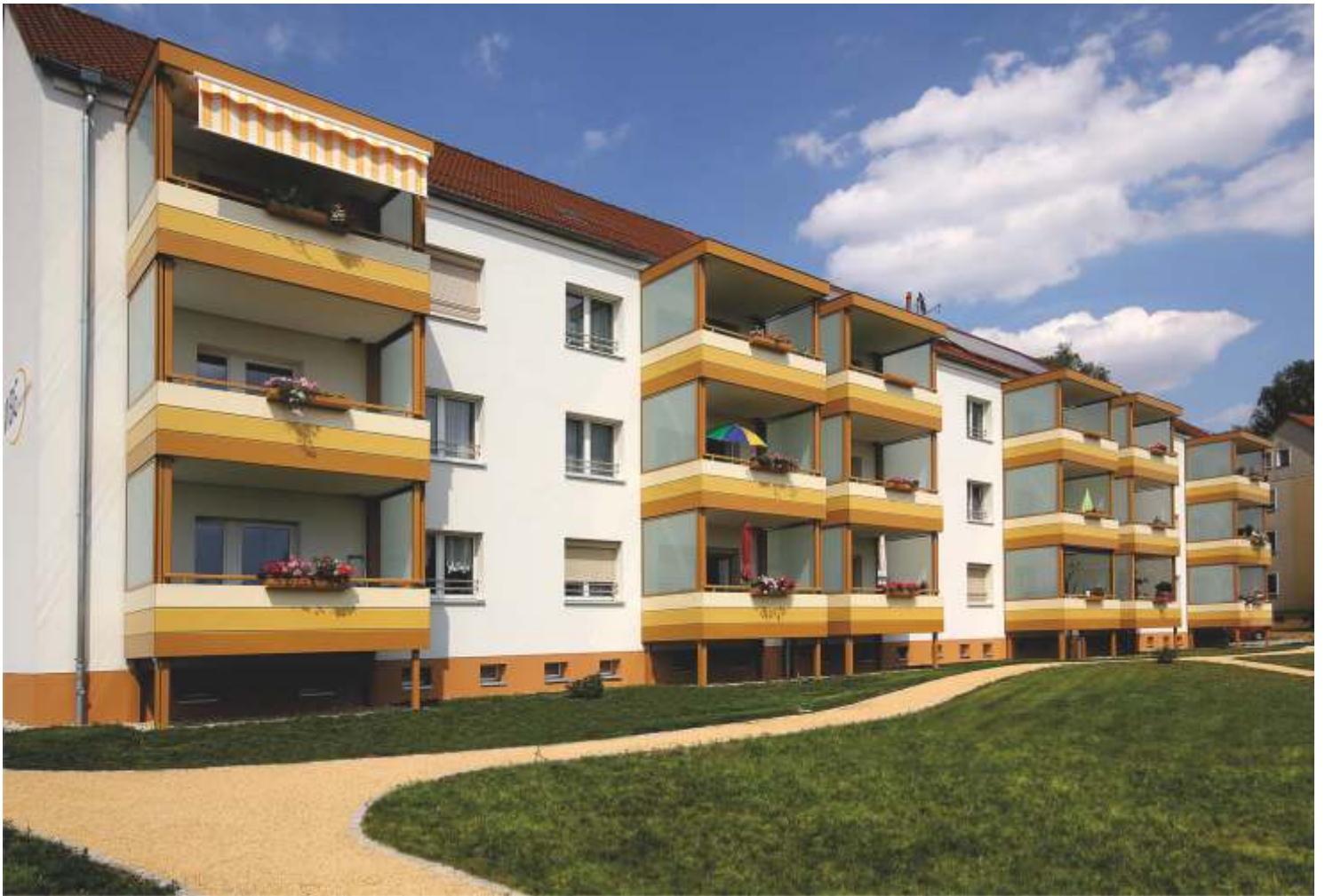
(1) Aluminium-Beton Balkone mit einem Geländer aus mehrfarbigen Blechkassetten
