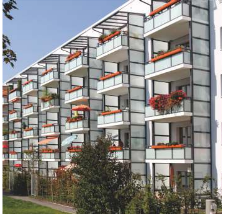
(15) Moderner Balkon in denkmalkonformer Optik; eng gesetzte Füllstäbe aus Alu-Kastenprofil 40x10
