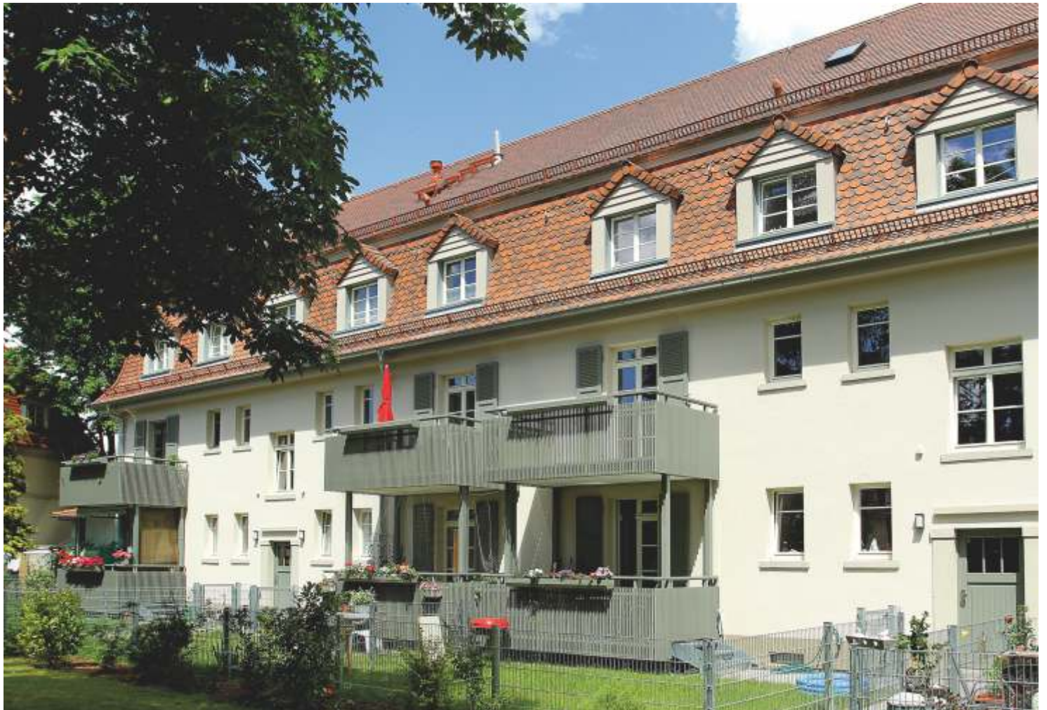
(15) Moderner Balkon in denkmalkonformer Optik; eng gesetzte Füllstäbe aus Alu-Kastenprofil 40x10
