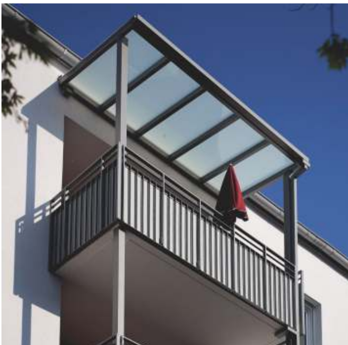
(6) Filigranes Stahl-Füllstabgeländer mit dahinterliegender HPL-Platte; Betonplatte verdeckt
